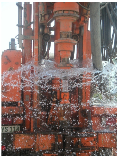
Artesischer Überlauf, Brunnenbohrung Regensburg
