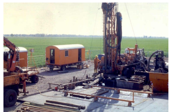
Baustelleneinrichtung einer Erkundungsbohrung
