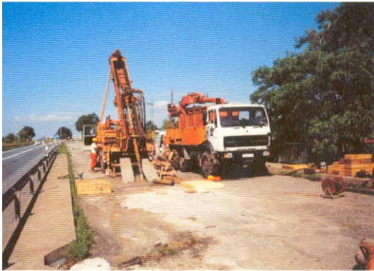
Geomechanik Bohranlage in Schrägbohraufstellung
