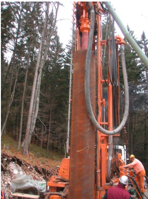
Aufgeschweißte Schutzverrohrung ca. 5 m Länge
