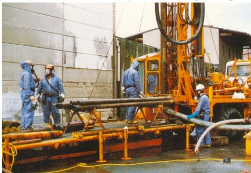
RB 20 - Bohranlage mit Druckkabine, Bohrcrew mit Vollschutz Gas-Absaugung über der Spülung
